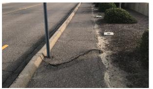
FIGURE 4.8.7. CRACKED SIDEWALK ON MARINA VIEWS
