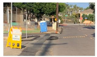
FIGURE 4.9.7. INCOMPLETE CURB AND RAMP ON CLIFF STREET NEAR SEABRIGHT LANE
